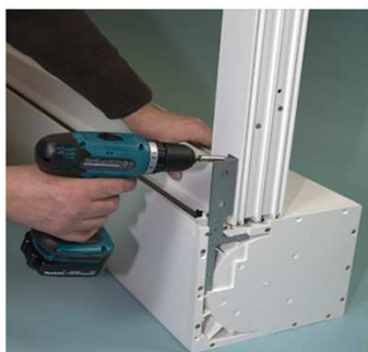
Befestigungsstiele anschrauben
